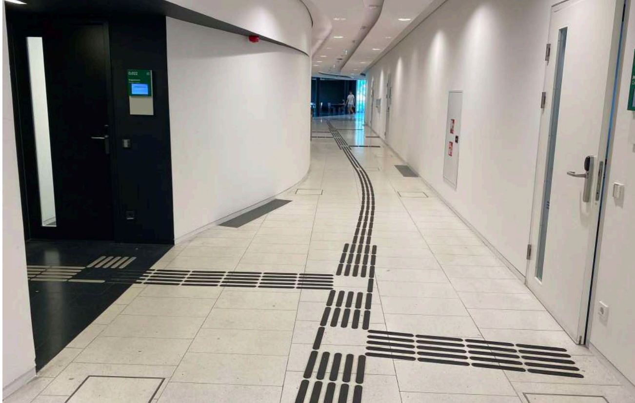
Fig. 114 Guide tattili che guidano il disabile visivo all'interno di uno degli edifici presenti in un campus universitario a Vienna.
