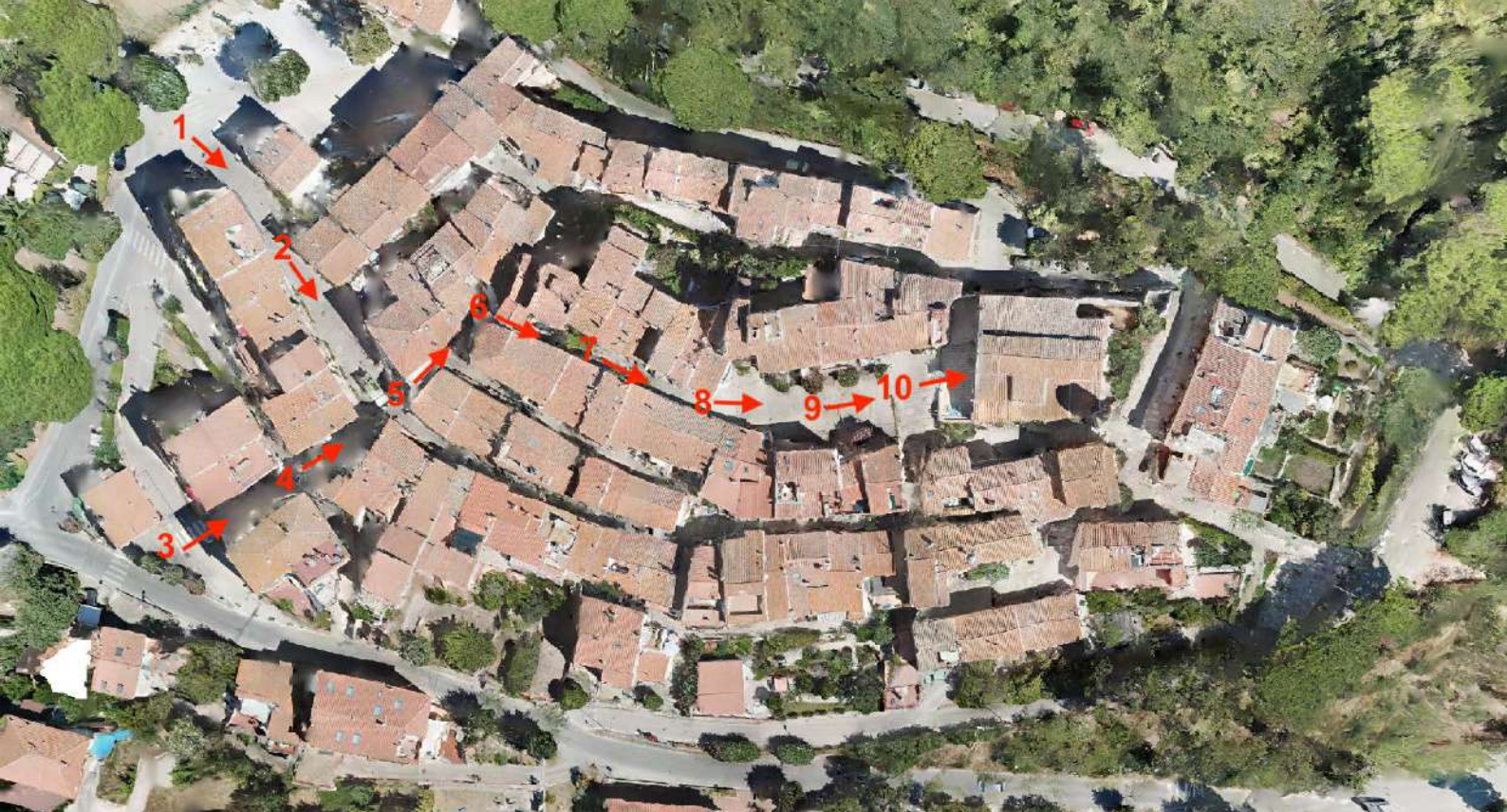
Fig. 25 Percezione di una successione consequenziale di forme architettoniche e paesaggistiche nel borgo di Sant'Ilario all'Isola d'Elba.
