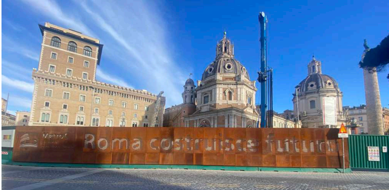
Fig. 262 Recinzione del cantiere della Linea C della metropolitana a Piazza Venezia, Roma.
