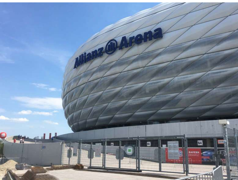
Fig. 258 L'Allianz Arena a Monaco di Baviera, è realizzata con un materiale estremamente innovativo, l'ETFE (Etilene Tetra Fluor Etilene), completamente riciclabile, utilizzato per rivestire una struttura con una sequenza "matelassé" composta da 2.874 cuscini a forma di rombo.
