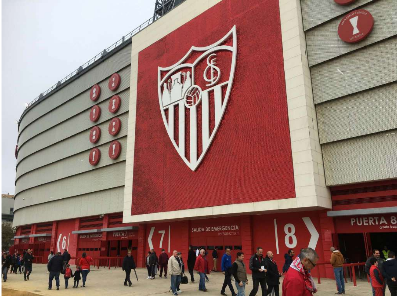
Fig. 265 Facciata dello Stadio Ramón Sánchez Pizjuán del Siviglia.
